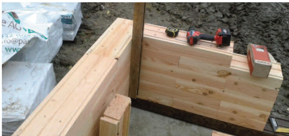
Le montage du PBM® est similaire au lego®, mais les plots ont été remplacés par des vis et des lèvres assurent l'étanchéité.
